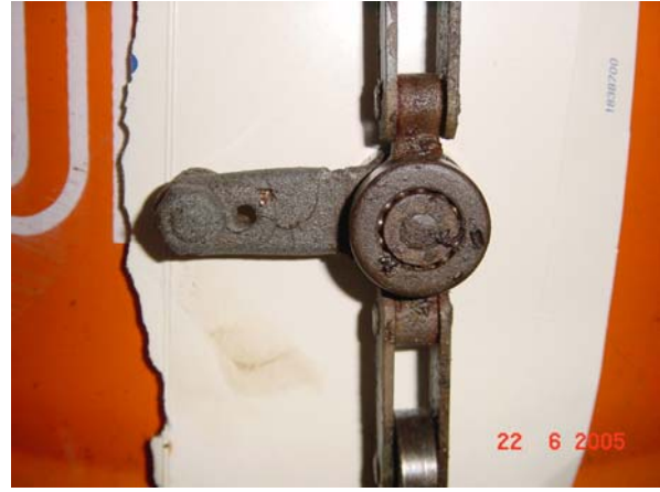
Kuvat 11. ja 12. 60 metrin linjoissa oleva rullayksikkö on n. 15 cm pitkä ja rullan halkaisija on noin 40 mm. Rulla-laakerin halkaisija on n. 20 mm. Rulliin keräytyvä lika erottuu kuvissa selvästi.
